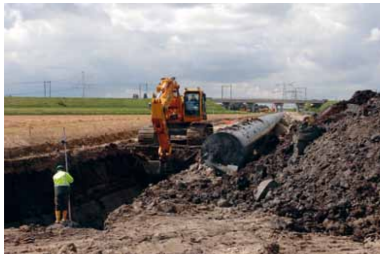
Aanleg van een 48" gaspijpleiding van 55 km voor Delta Energy.
