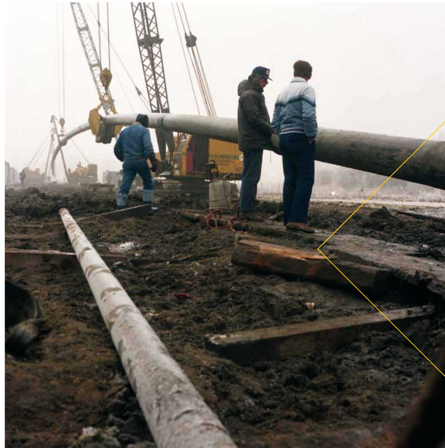
Samen met het Texaanse bedrijf Berco voert A.Hak de eerste lange horizontaal gestuurde boring van West-Europa uit. Voor Gasunie wordt het Buiten-IJ gekruist over een lengte van 620 meter.
