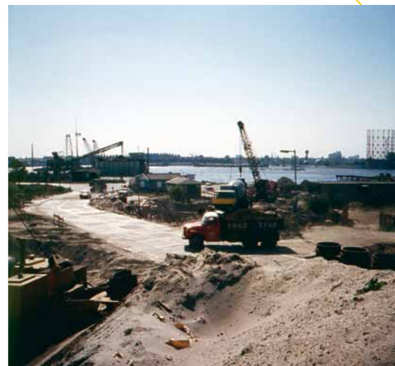
Aanleg van een dubbele waterleiding bij de Van Brienoordbrug bij Rotterdam.
