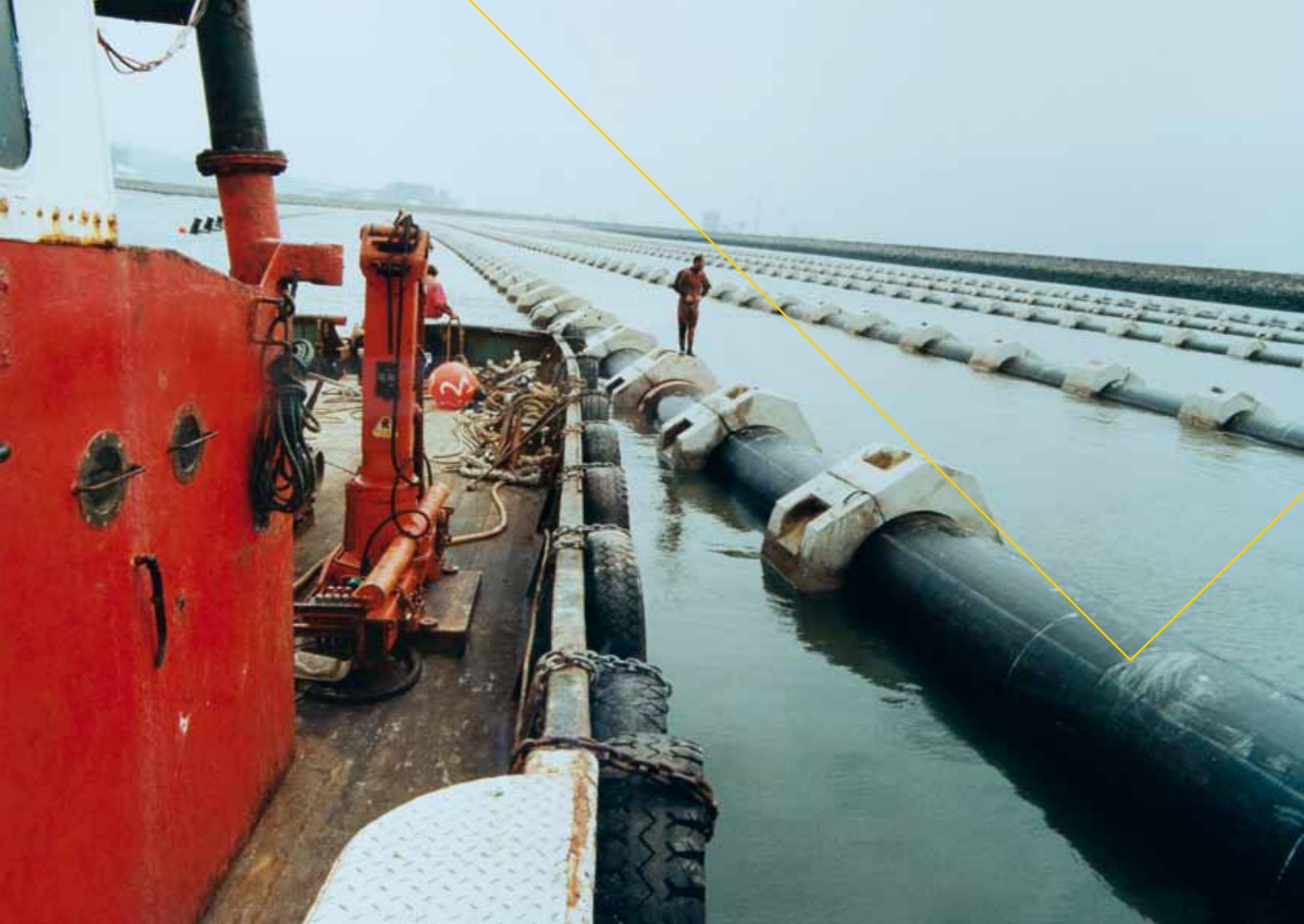
Voor Wales Water installeerde A.Hak een outfall in Swansea Bay, Zuid-Wales. Normaal gesproken werden dergelijke pijpen in stukken van 12 meter aangevoerd en ter plekke samengesteld, maar A.Hak liet ze door de Deense leverancier in twee bundels met stukken van elk 500 m over zee naar Wales varen.
