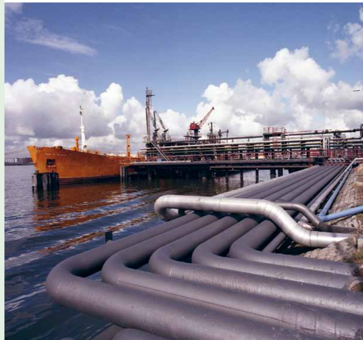
Nadat A.Hak de Paktank pier volledig heeft vernieuwd, wordt het eerste schip er geladen.
