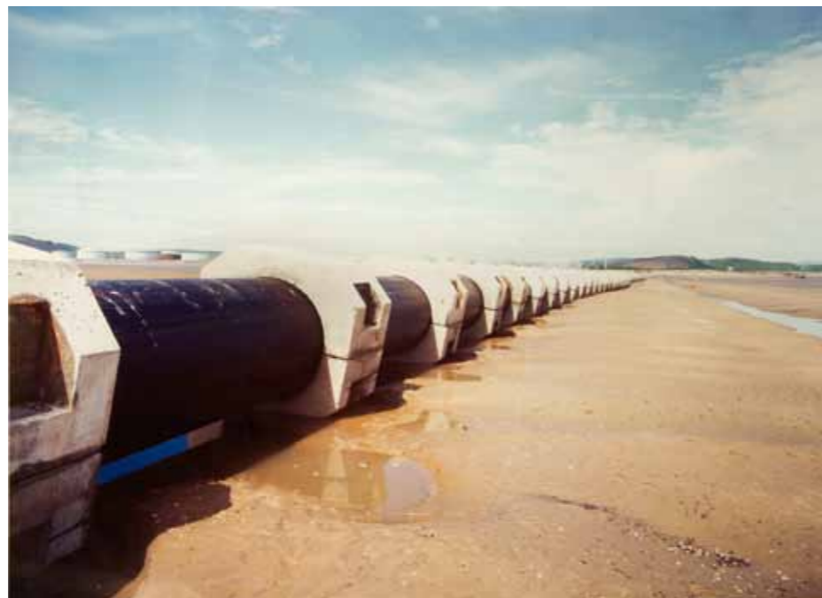
Voor Wales Water installeerde A.Hak een outfall in Swansea Bay, Zuid-Wales. Normaal gesproken werden dergelijke pijpen in stukken van 12 meter aangevoerd en ter plekke samengesteld, maar A.Hak liet ze door de Deense leverancier in twee bundels met stukken van elk 500 m over zee naar Wales varen.
