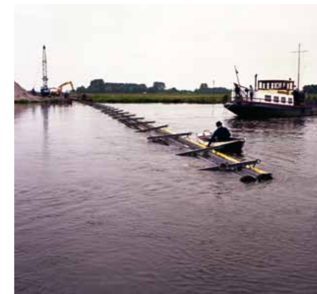
De aanleg van een gecombineerde zinker in het Noorddiep door de vestiging Hatterm.
